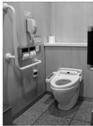
一般トイレ内で車いす利用者が 利用できるトイレ
