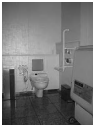
多目的トイレ (写真右に折りたたみベッド) 写真2 トイレの種類
